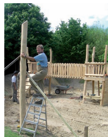
In einer Rekordzeit von zwei Tagen wurde das Klettergerüst gebaut
